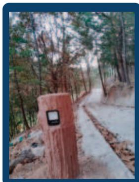
Instalación de 42 troncos de cemento imitación árbol en donde se instalaron las lámparas, y cableado para iluminar los caminamientos.
