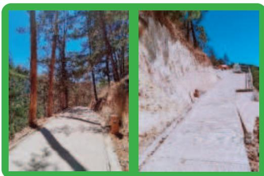
Fundición de 323.52 metros de cemento de 1 metro de ancho por 15 cm de grosor, para caminamiento hacia las cabañas en donde va a ingresar el vehículo Qute.
